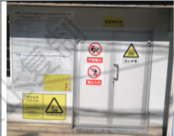
依托总厂危废暂存间外部
